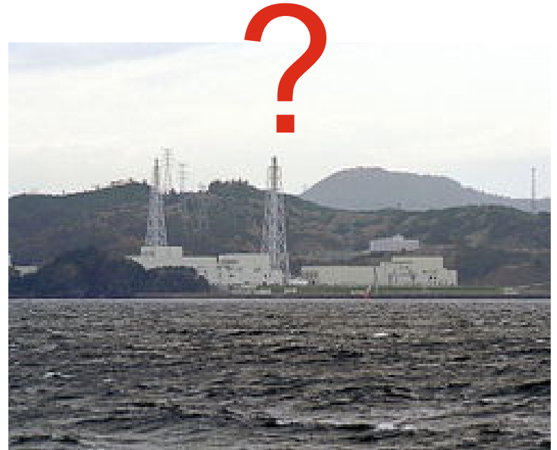
原子力発電所
